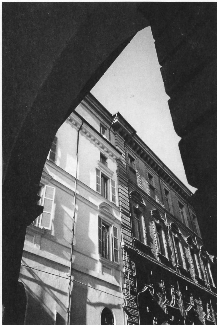
Fig. 11: Palazzo dell'Università, Prospetto su via Vasco: sono chiaramente visibili le differenze di livello dei piani superiori a quello di terra, poste in evidenza ancor di più dal diverso trattamento, ad intonaco ed a mattone a vista, delle due parti che compongono la cortina (Foto Rita Binaghi).
