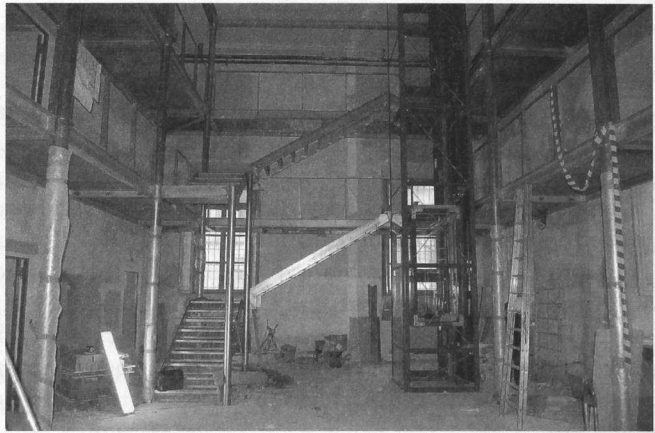
Figura 1. Archivio storico: il cantiere.
